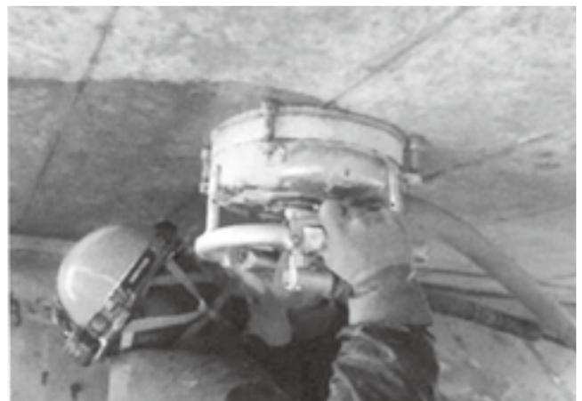
図表7 コンクリート表面処理工 ハンドガンタイプ
