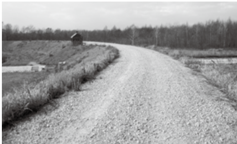
図表4 復旧後の札内川KP25.0堤防
