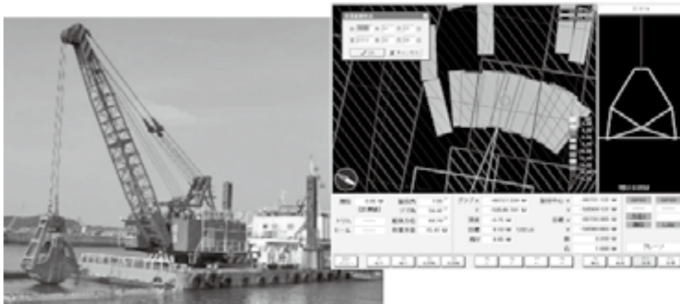
図表2 ICT浚渫工(施工の可視化)
