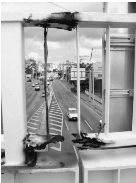
図表11 メンテナンスを放棄した横断歩道橋
