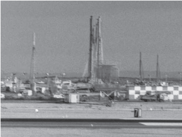
図表8 第1レーダのゴースト対策で直線状に並んだ 沖合展開部の地盤改良機
