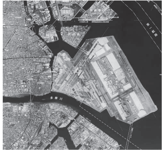
図表4 東京国際空港沖合展開事業と東京湾岸道路（1999年10月10日撮影）
