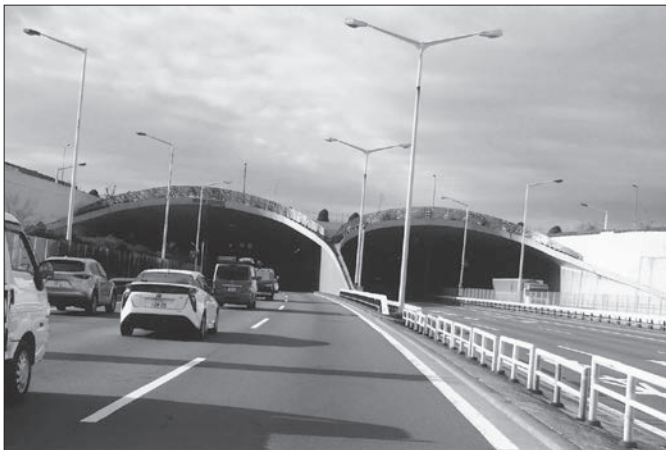
空港北トンネル・横浜側坑口
