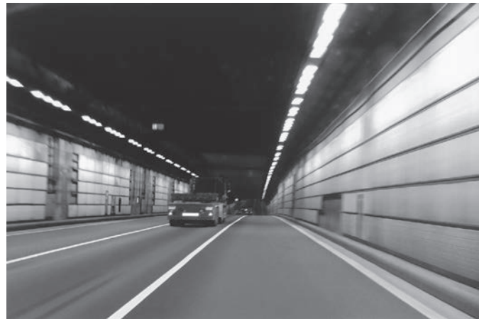
空港北トンネル・旧B滑走路アンダーピニング部 前方のサグ部は京浜南運河部
