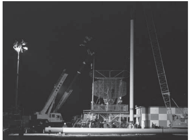
図表7 空港監視レーダ（No1 ASR）の補強
