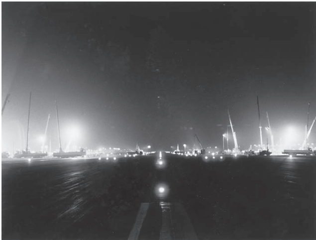
図表6 滑走路上に展開した地盤改良機
