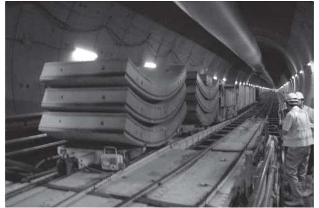
写真4 トンネル工事現場
