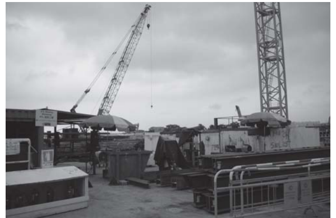
写真5 ヤードに置かれた鋼材
