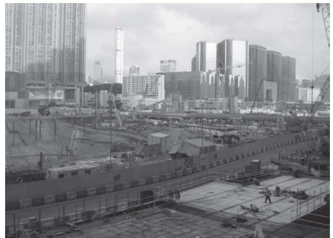
写真2 西九龍駅工事現場全景
