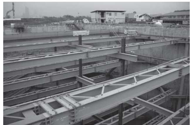
写真6 トンネル換気口内の切梁支保
