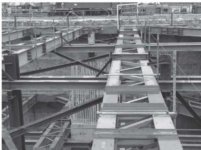
写真2 日本の建設会社の地下鉄工事現場で使用される形鋼類
