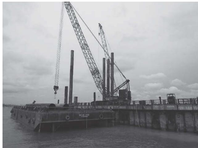
**写真4** MCE工事現場。手前に締め切りのための鋼管矢板が打設されている。奥では鋼管矢板の引き抜き作業が進められていた。
