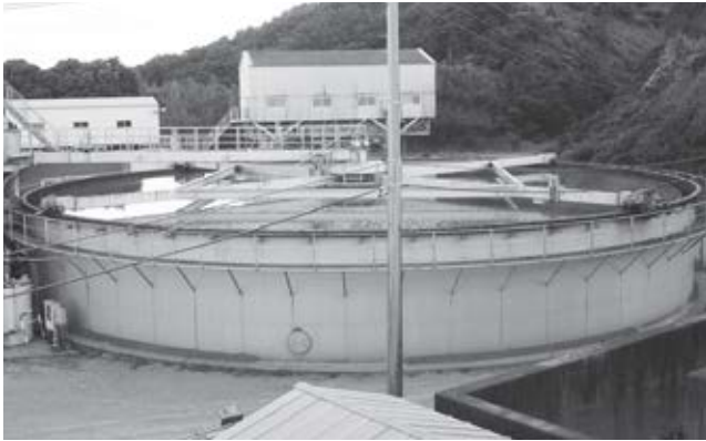
図表8 沈殿装置(シックナー)
