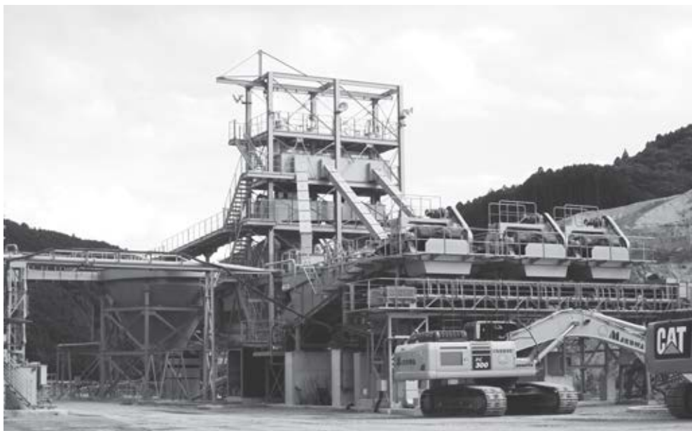
図表10 設備全体
