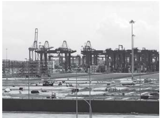
図表9 南部の港湾施設。コンテナヤードに隣接して 現在も埋立工事が続いている
