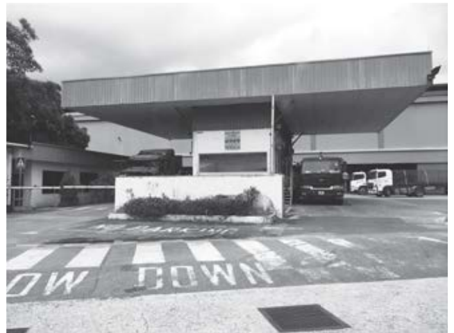
図表15 シンガポール唯一の電炉工場 異形棒鋼を生産している
