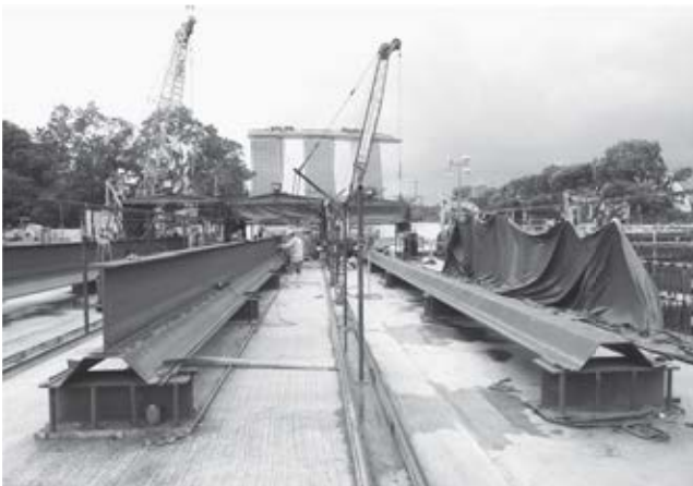
図表13 建設現場でのハット+Hの溶接加工
