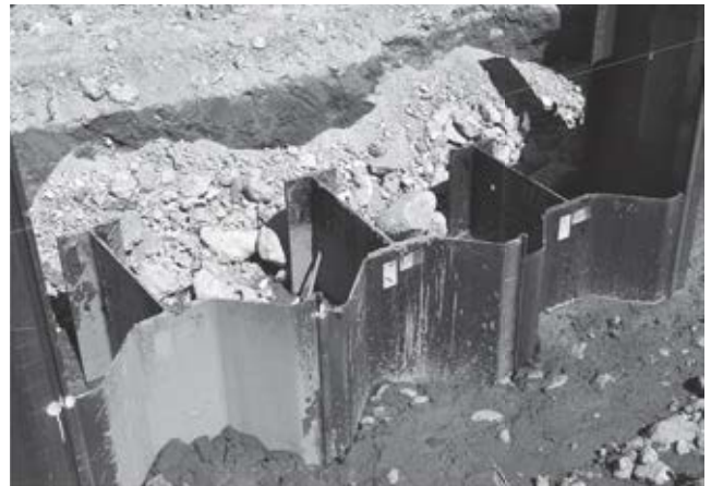
図表14 打設後のハット+H
