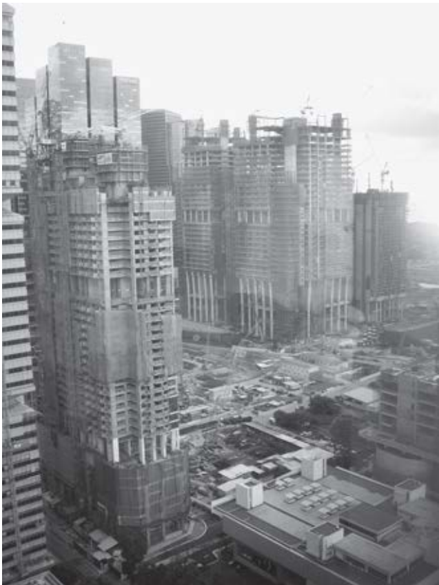
図表8 中心部にある高層ビルの建築現場複数のビル 工事が行われていた
