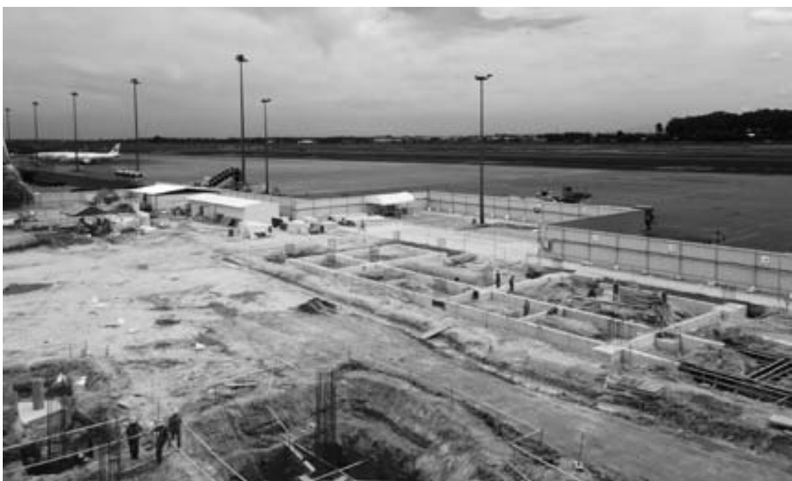
図表15 ビエンチャン国際空港ターミナル拡張事業の施工風景
