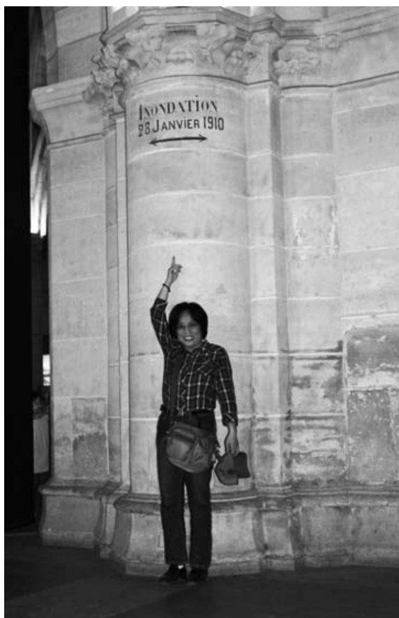
写真11 コンシエルジュリー エントランスホールの洪水痕跡(佐川撮影)
