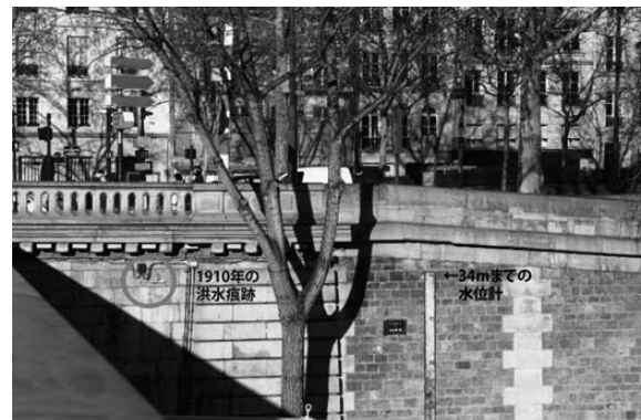
写真3 ルイ＝フィリップ橋南詰にある水位計と洪水痕跡 (佐川撮影)
