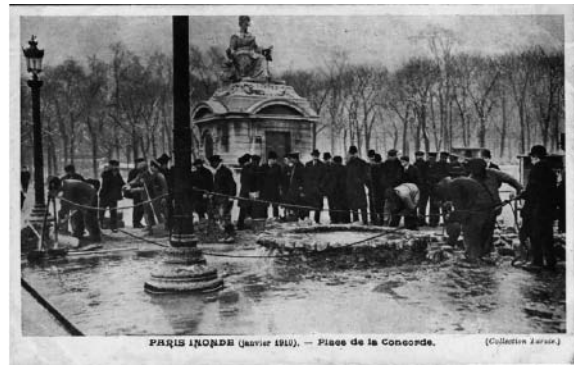
写真6 浸水が始まったコンコルド広場(写真はがき)
