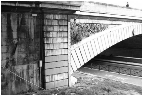
写真2 オーステルリッツ橋の水位計 (佐川撮影) 写真中央に5m～10mの水位計 左手橋台中央付近に1910年の洪水痕跡
