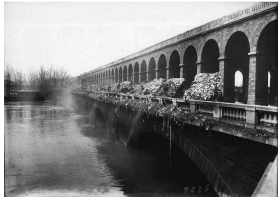
写真7 オートゥイユ橋からのゴミ投棄(佐川美加「パリが沈んだ日—セーヌ川の洪水史」(白水社)より)
