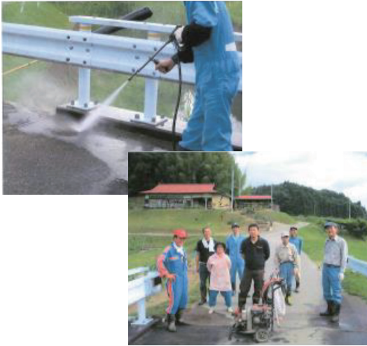
住民による橋の清掃活動。各行政区では年4回道路愛護作業や草刈りなどの作業を行っているが、そのうちの2回で橋梁点検と清掃活動も付随して実施している。
