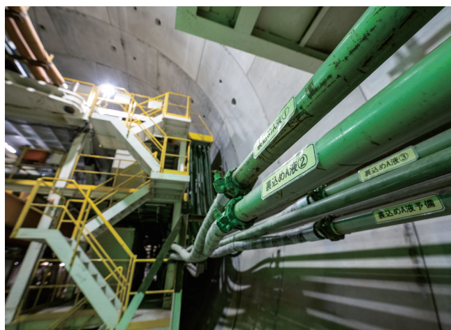
通路や配管などの仮設工事。計画時には、配管であれば「後々延長していくことや、資材を運ぶ邪魔になってはいけないことなど、色々なことをあらかじめ想定する」とのこと。作業員の力量に配慮した設備を計画するのも腕の見せどころ。
