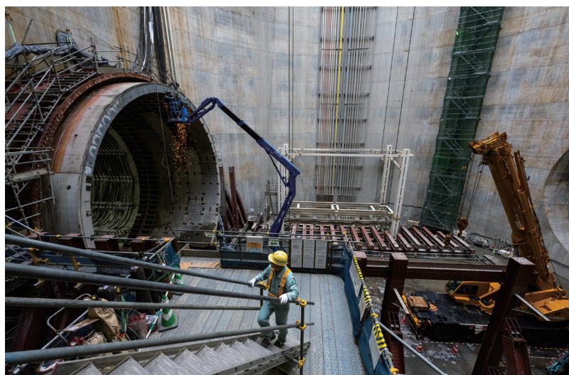
山口さんが携わる「中央新幹線第一首都圏トンネル新設（梶ヶ谷工区）ほか」。第一首都圏トンネルの全長は、東京都港区から神奈川県相模原区までの約37km。
