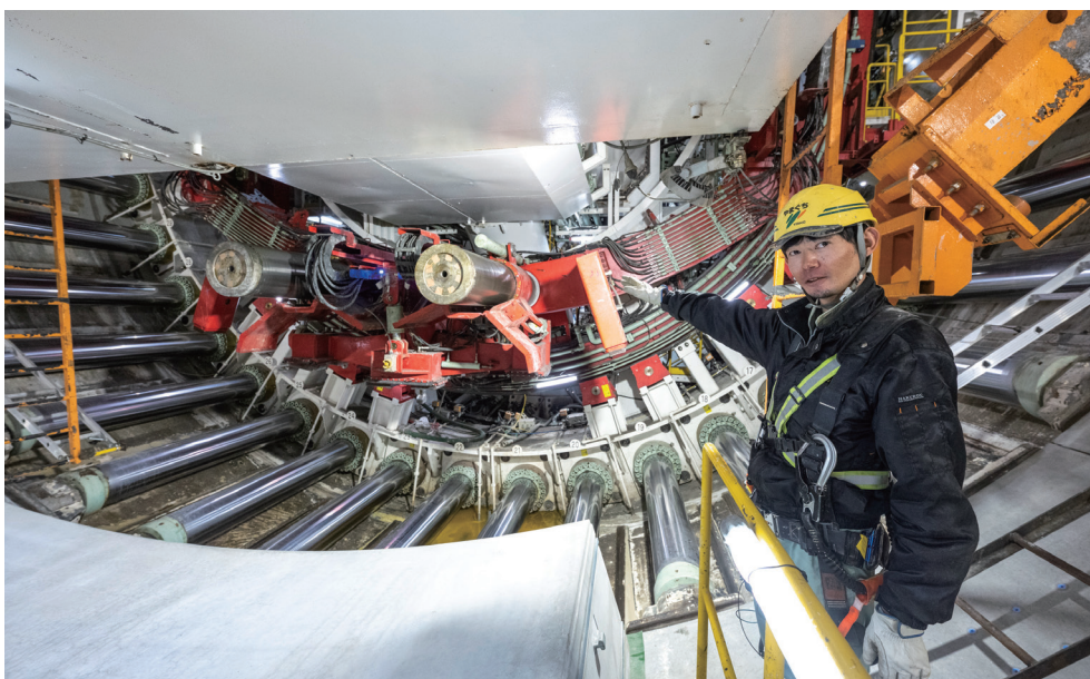
工場のようなシールド工事現場。シールドマシンでの掘削後、セグメントを組み立ててトンネルがつくられていく。シールドマシンはコンピューターで制御されており安全性は高いが、現場での細やかな配慮は欠かせない。
