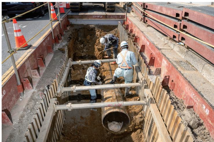
思わぬ埋設物が出てくることもある水道管の取り替え工事。想定外の埋設物が出てきた場合には工事がストップしてしまうため、試掘は念入りに行われる。
