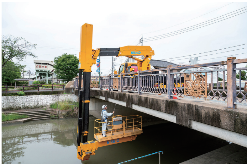
橋梁点検の様子。同社では道路や農業土木施設などの点検も行うが、橋梁はとりわけ多く、昨年（2024年）は約50橋程度の点検を行った。
