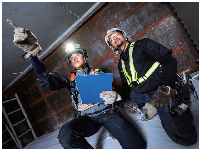
作業員との密なコミュニケーションを通じて、施工が円滑に進むよう日々努めている。
