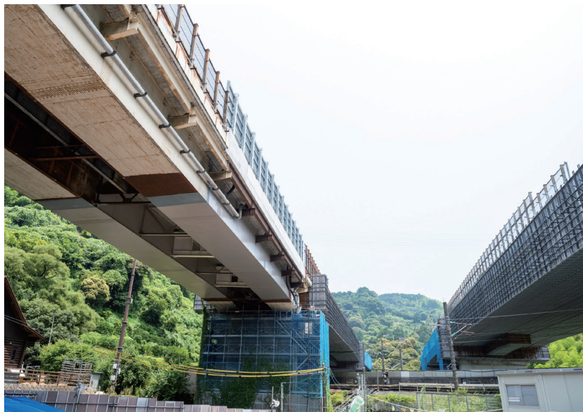
阿武さんが現在従事している、「清見寺橋他1橋床版取替工事」の現場。東名高速道路という物流の大動脈の一部であるため、厳密なスケジュール管理が欠かせない。
