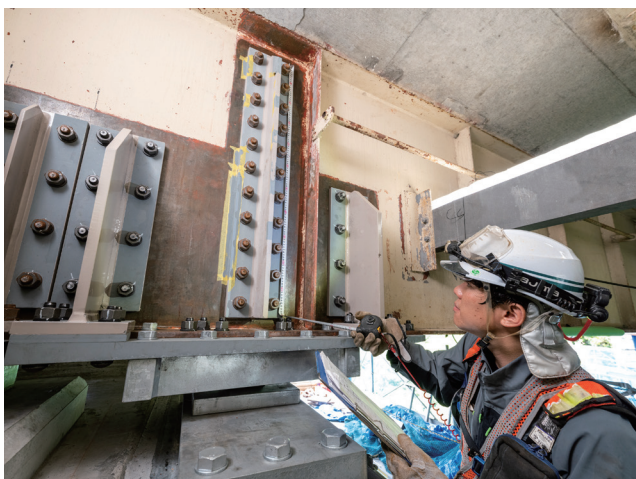
支取替が完了した後の出来形検査の様子。全体の工程管理を着実にしつつ、品質確保にも細心の注意を払う。
