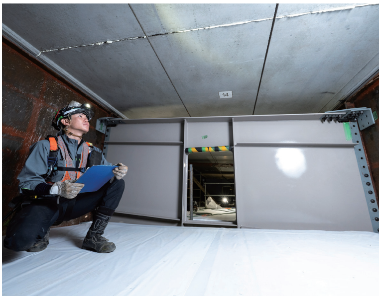
床版取替工事を終え、新設された下面の横桁をチェック。「この現場にはヤードの整備段階から関わっていて愛着があります。一つ一つの工程を着実に積み重ねて、現場が少しずつ形になっていく過程にやりがいを感じます」と話す。
