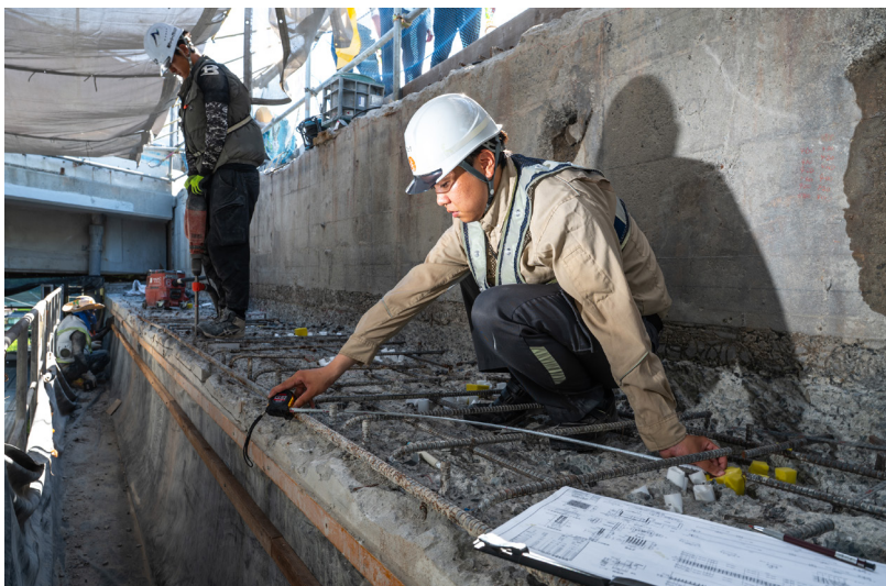
現在担当している下本村川橋の現場で作業している様子。施工箇所が図面通りに仕上がっているのかを、計測して確認している。
