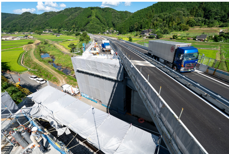
現在担当している下本村川橋の全体写真。既設桁の撤去が完了し、新設桁の架設に向けた準備作業を進めている。
