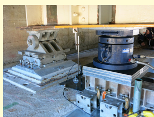
油圧ジャッキと変位計
