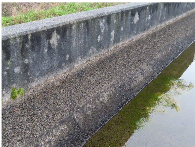
現地水路の摩耗状況（左：側壁／右：底板）。摩耗が進むと、通水性能が低下して溢水などの被害が生じる恐れがある。被害を未然に防ぐには、適時適切な診断や補修を行うことが重要である。
