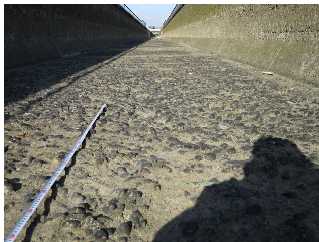
現地水路の摩耗状況（左：側壁／右：底板）。摩耗が進むと、通水性能が低下して溢水などの被害が生じる恐れがある。被害を未然に防ぐには、適時適切な診断や補修を行うことが重要である。
