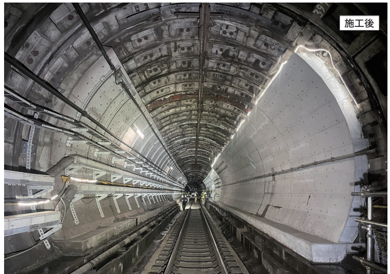
変形が確認されたシールドトンネル区間の、補強前（上）と補強後の様子（下）。長期的な安全性を重視し、変形の進行を抑制する構造補強が施された。
