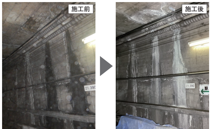
止水工事における施工前（左）と施工後（右）の様子。早めに対応することで、乗客への影響を未然に防ぐ。
