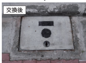
ます蓋(右)ます蓋の老朽化に伴い、新品へ交換。マンホール(左)周辺舗装の剥がれやガタツキを改善するため、人孔蓋・枠・舗装部分を補修。
