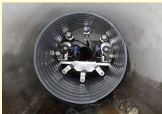
小口径管の更生（元押し式）
