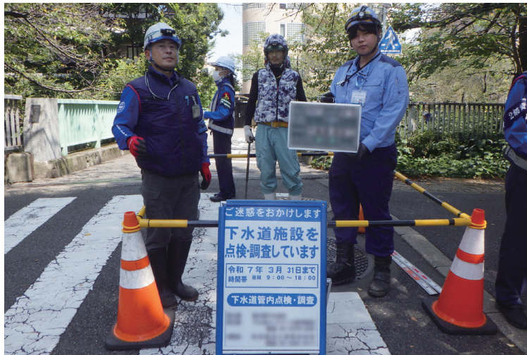
分水人孔点検に立ち会い、下水道施設の状況の一つひとつを確認。確実な点検で下水道の安全を支えている。
