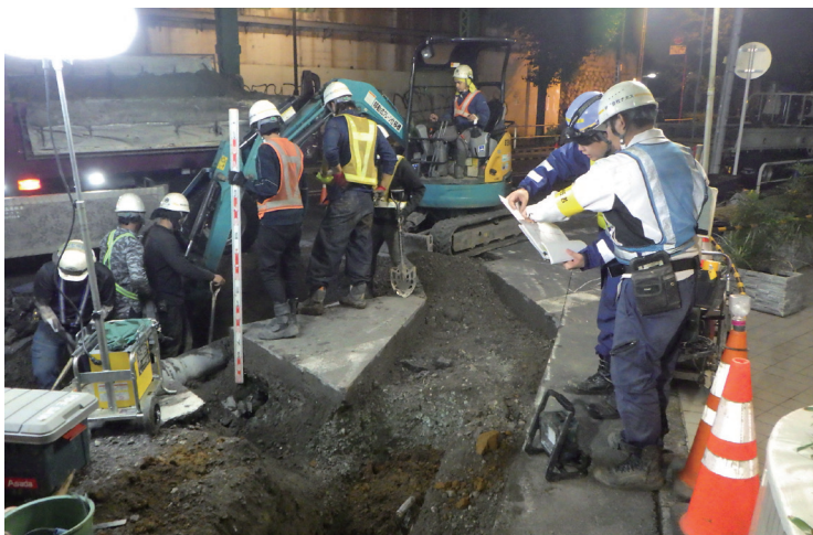
夜間に行われる各種工事を対象に、週1回の夜間パトロールを実施。下水道施設への影響や異常がないかを確認し、事故や損傷を未然に防ぐための巡視を行っている。
