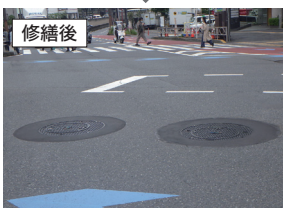
ます蓋(右)ます蓋の老朽化に伴い、新品へ交換。マンホール(左)周辺舗装の剥がれやガタツキを改善するため、人孔蓋・枠・舗装部分を補修。
