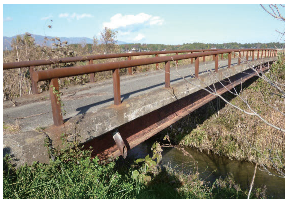
【図-1 地方自治体の劣化橋梁】
