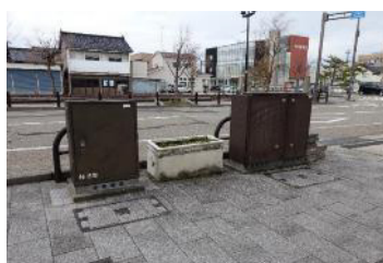
特殊部、地上機器部に被害は確認できない
