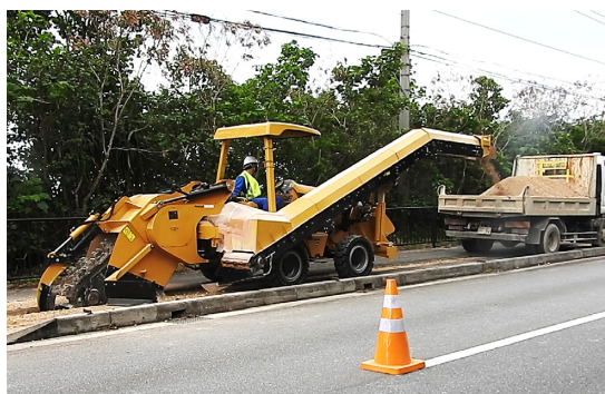
【写真-1 トレンチャーでの掘削・積み込み状況】
