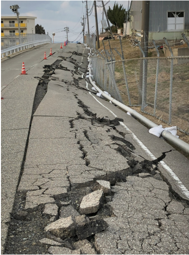
【写真-1 緊急的に路面上に復旧された水道管】 (輪島市：令和6年3月著者撮影)
