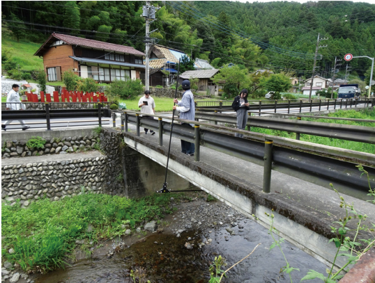
【図-3 桁下点検装置】
