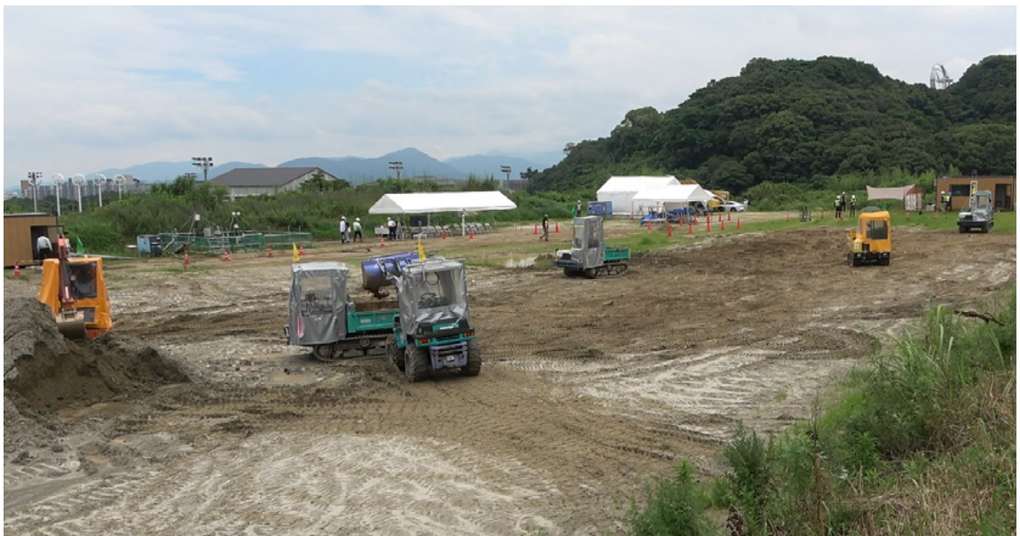
【複数台小型建設ロボットの協働による土砂運搬作業】
