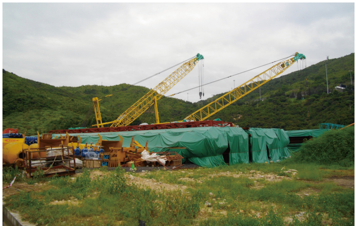
写真-7 人工島付近の鋼材ヤードに置かれた鋼矢板。日本の北九州から運搬され出番を待つ。緑色のシートの下に直線鋼矢板が保管されている
