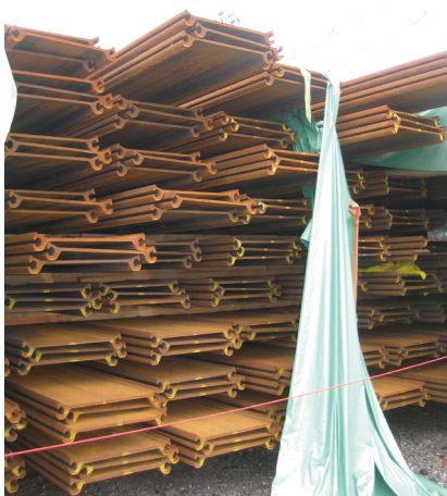
写真-7 人工島付近の鋼材ヤードに置かれた鋼矢板。日本の北九州から運搬され出番を待つ。緑色のシートの下に直線鋼矢板が保管されている
