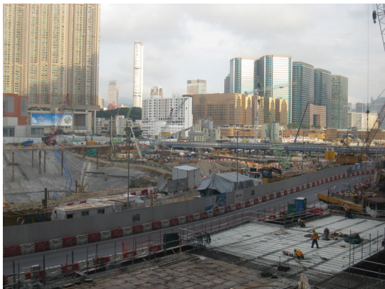
写真-2 西九龍駅工事現場全景。香港新幹線の発着ターミナルへと変貌する
