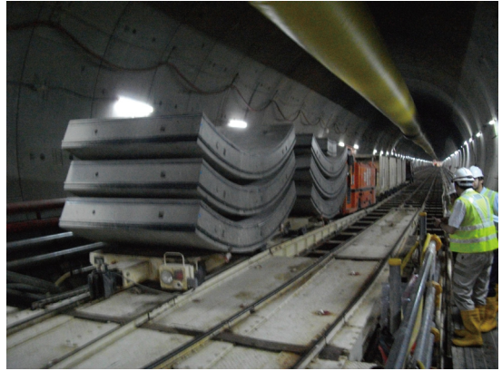
写真-4 トンネル工事現場。中国本土で製造されたセグメントが坑内に運ばれていく
