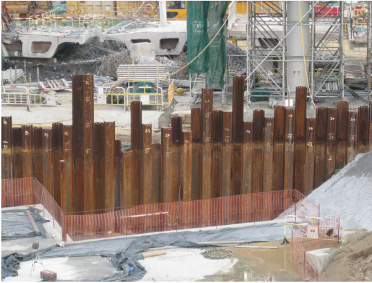
写真-3 同工事現場。鋼钢板が大量に使用されている
