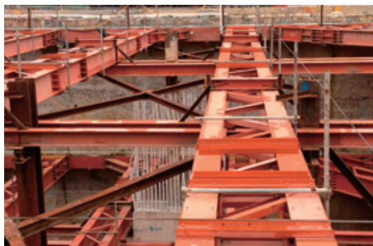
写真-2 日本の建設業者の地下鉄工事現場で使用される形鋼類
