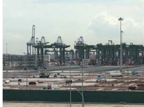
写真-4 南部の港湾施設。コンテナヤードに隣接して 現在も埋立工事が続いている
