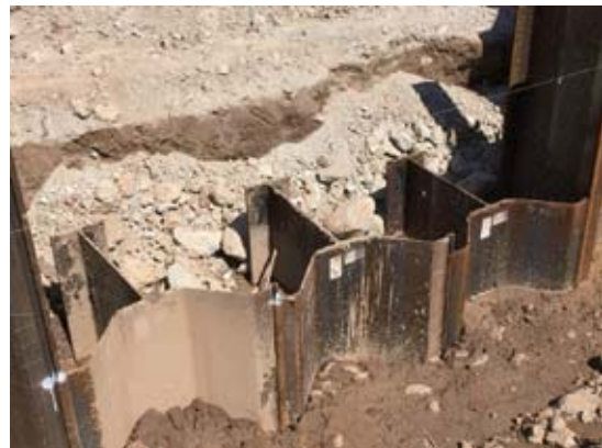
写真-7 打設後のハット+H
