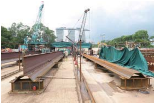
写真-6 建設現場でのハット+Hの溶接加工
