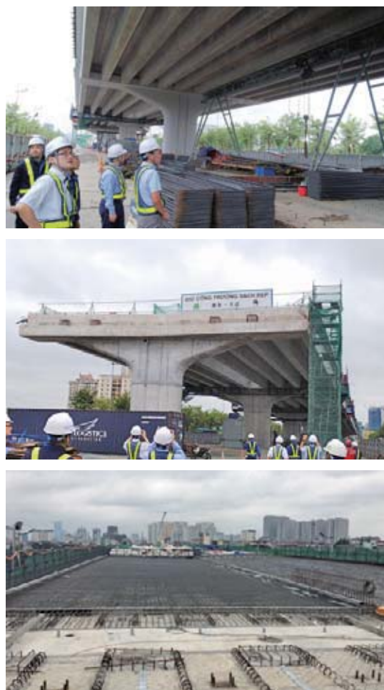
図表-15 ハノイ環状3号線工事
