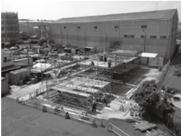
写真-2 教育訓練風景 (八潮 実習ヤード)
