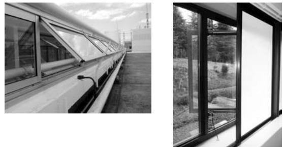
写真-10 トップライト開口と窓開口
