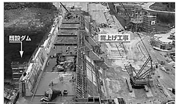
図-9 堤体の高上げ(三高ダム)
