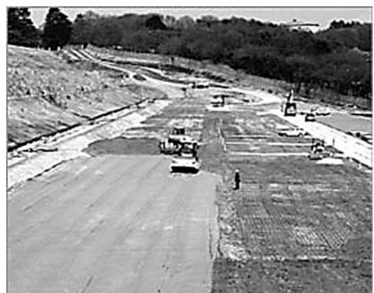
図-10 堤体の耐震補強(山口貯水池)
