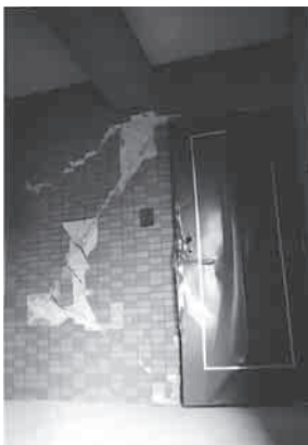
写真-3 各住戸の玄関扉の被災例
