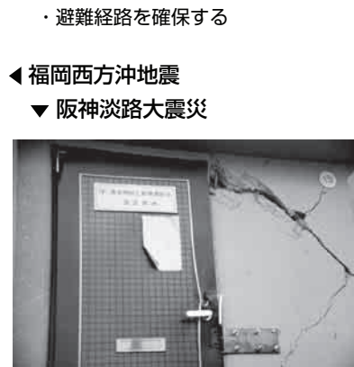
写真-3 各住戸の玄関扉の被災例
