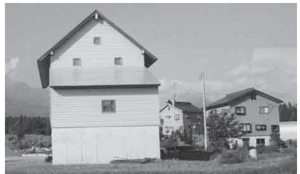
写真-2 新潟県中越地震(2004年、M6.8)で被災していない雪国仕様の住家の例
