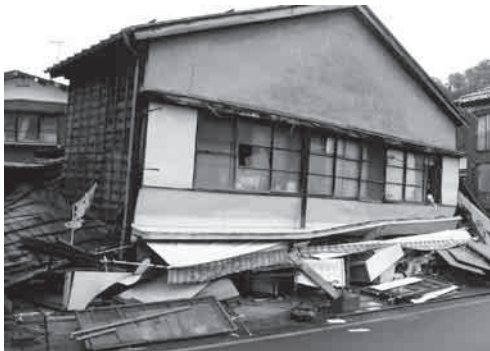
写真-1 新潟県中越地震(2004年、M6.8)で被災した建物の例
