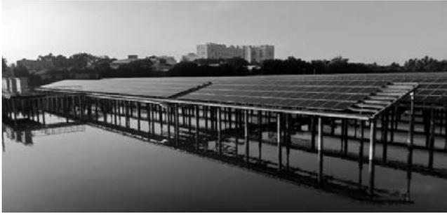
台北の西側に位置する桃園市に設置されている設備で、浮体式と支柱式の2ヶ所を訪れたが、いずれも地元の水利組合が管理する調整池を発電事業者が借り受ける形で導入されており、水上部分の賃借料と売電収入から還元された収益の一部が水利組合に支払われ、地域の農業振興に活用される計画と聞いた。
