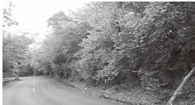
図表3 自然回復した道路法面 2)
