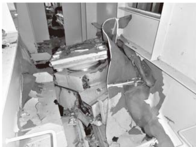
図表6 破損した支承（株）IHIインフラシステム提供
