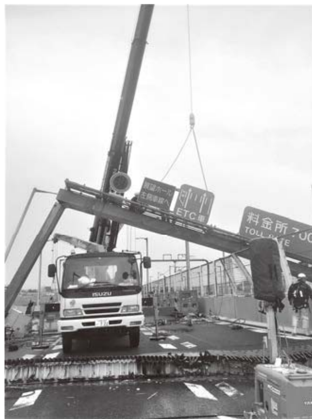
図表8 破損・変形した標識柱（株）IHIインフラシステム提供
