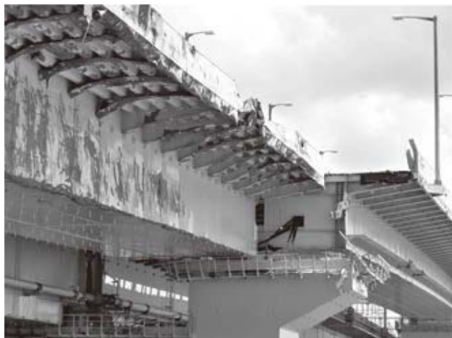
図表5 大きく横ズレし損傷した第2スパン桁 （株）IHIインフラシステム提供
