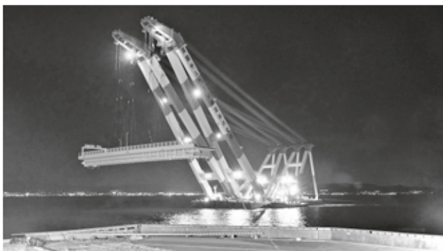
図表10 FC船で架設される再製された桁 (株)IHIインフラシステム提供)
