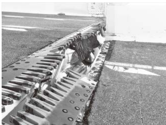
図表7 破損した伸縮装置（株）IHIインフラシステム提供
