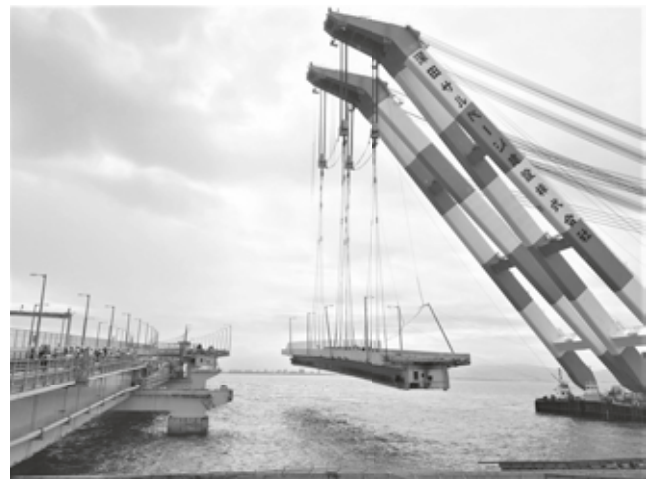
図表9 FC船で吊り上げられ撤去される損傷した桁（（株）IHIインフラシステム提供）
