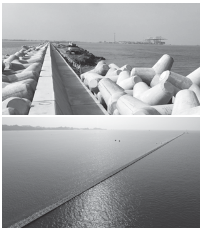
図表16 ラックフェン国際港工事
