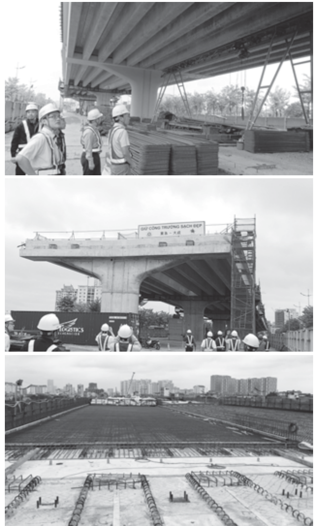
図表15 ハノイ環状3号線工事
