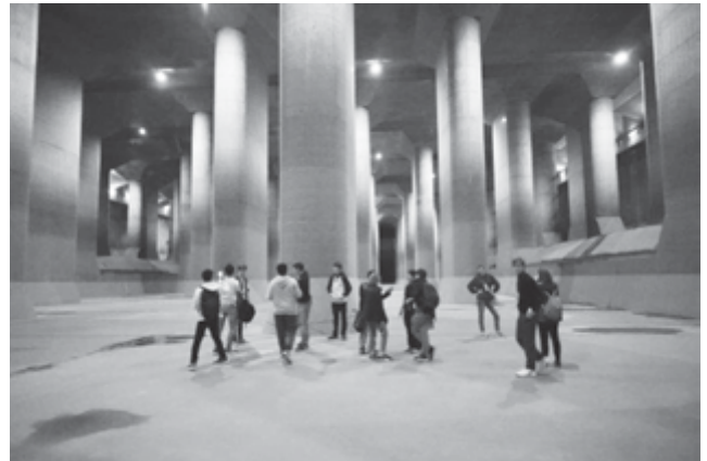
図表1 首都圏外郭放水路
