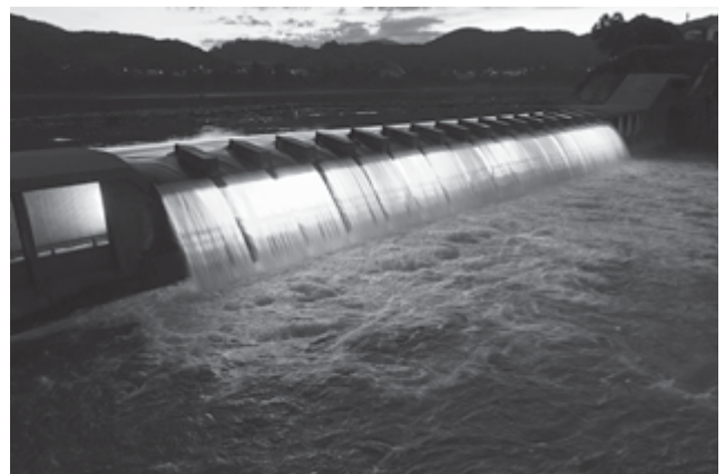
図表2 湯田ダム湖内の貯砂ダム(錦秋湖大滝)
