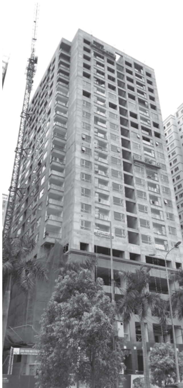
図表3 ハノイ市内 ～ マンションの建設ラッシュが続く ～
