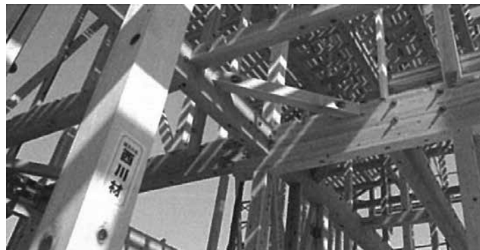
図表10 西川材を用いた躯体
