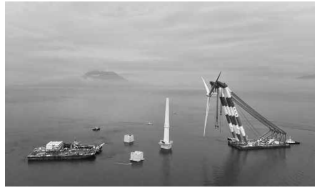
図表24 鹿児島県錦江湾でのFukushimaFORWARD 7MW風車の解体作業
