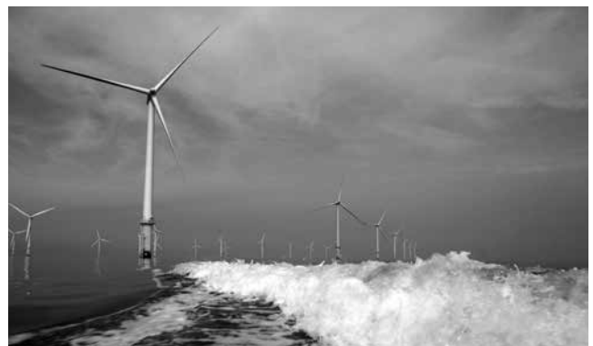
図表17 世界最大の洋上風力発電所 Hornsea 1 (英国北海沖120km、2020年2月運開、7MW風車×174台=1,214MW)
