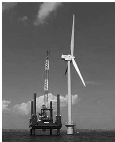
図表28 NEDOの着床式洋上風力発電実証事業 銚子沖の2.4MW、重力式基礎 北九州市響灘沖の2MW、ジャケット式基礎
