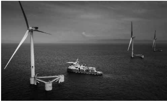
図表23 WindFloat Atlantic浮体式洋上風力発電所 (2020年7月運開、8.4MW×3基、セミサブ式)
