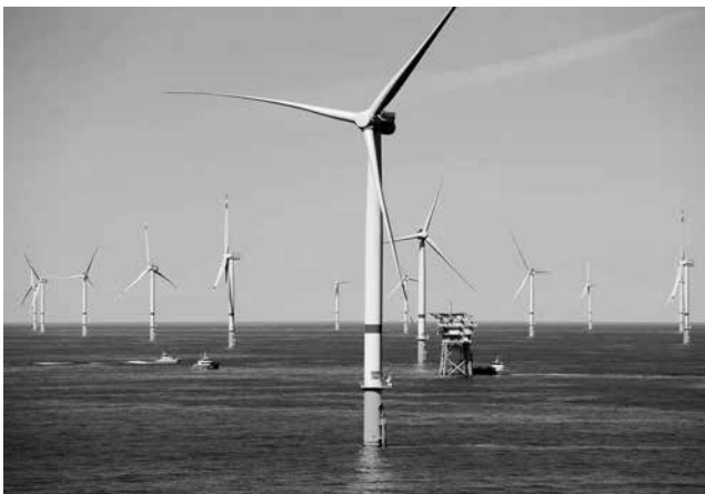
図表1 英国アイルランド海のWalney Extension洋上風力発電所(離岸距離19km、2018年9月運開、8.25MWと7MWの風車が87基で659MW)
