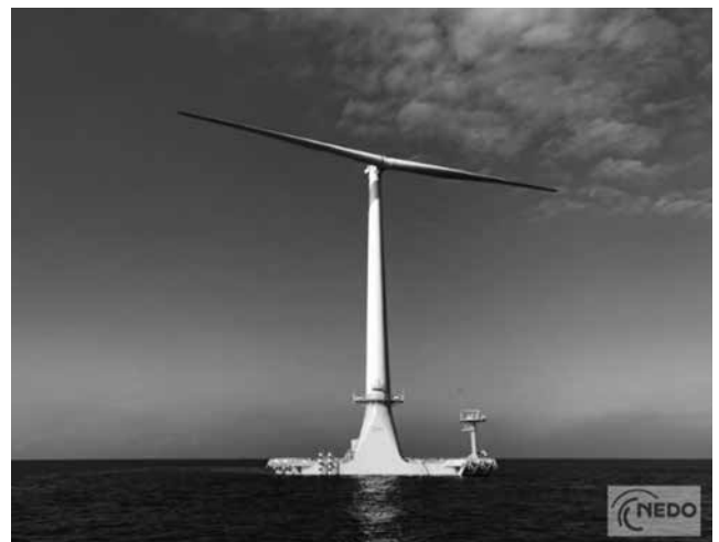
図表25 NEDOの次世代浮体式洋上風力実証プロジェクトの2枚翼風車（北九州市響灘沖15km、2019年運開。バージ型浮体）
