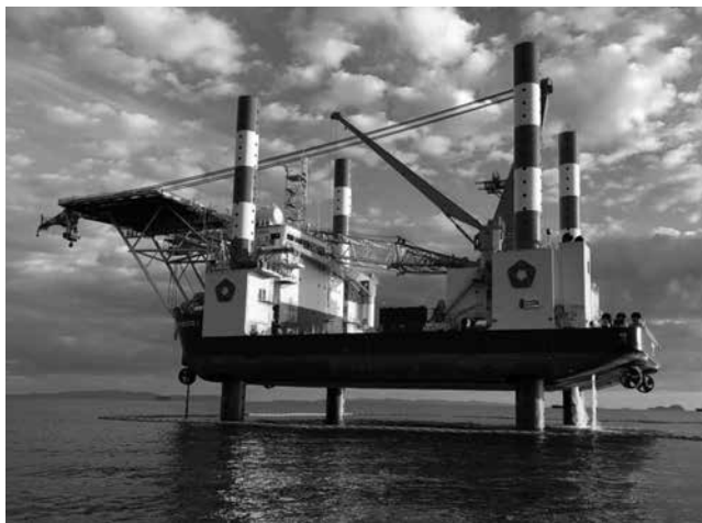
図表10 洋上風車の建設専用船Jack up vessel (五洋建設の「CP-8001」)
