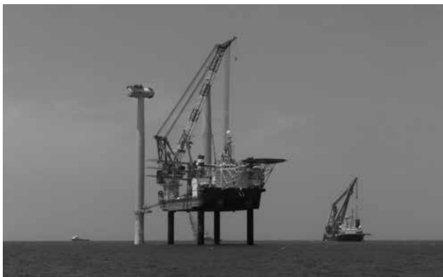
図表5 台湾のFormosa1 Phase2洋上風力発電所 (2019年11月に運開。6MW×20基=120MW、モノパイル基礎)の建設風景
