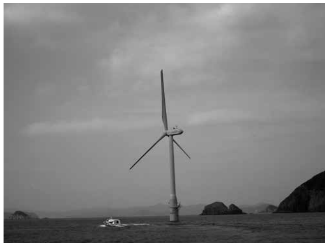
図表29 環境省の浮体式洋上風力発電実証事業GOTOFOWT (長崎県五島市、2013年運開、2016年に福江島に移設、2MW、スパー型)
