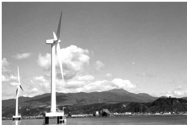
図表26 日本初の洋上風力発電(北海道せたな町、600kW×2基、ドルフィン基礎)
