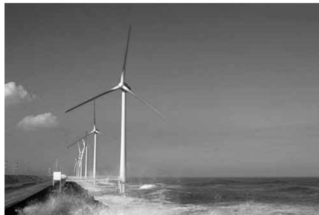
図表27 ウインドパーサー神栖洋上風力発電所(茨城県神栖市、2MW×15基、モノパイル基礎)
