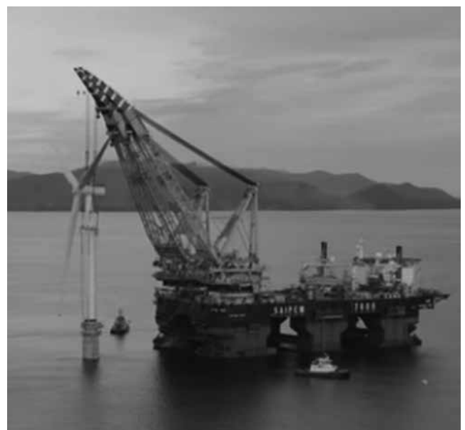
図表21 Hywind Scotlandでの風車据付作業
