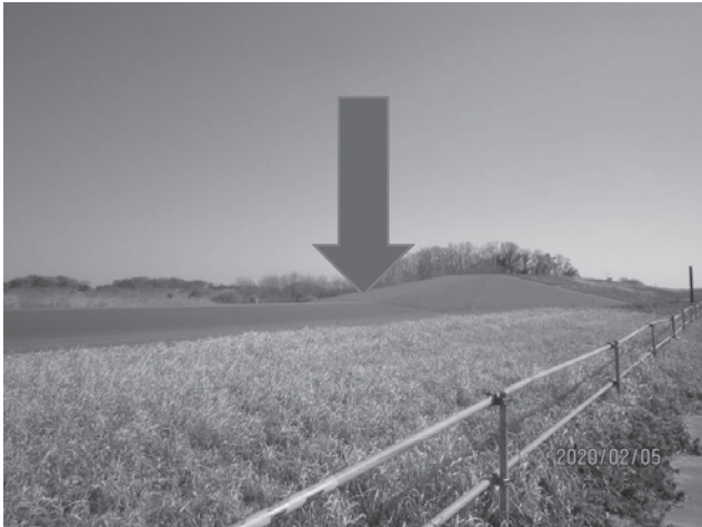
図表7 堤防一部が低くなっている利根川堤防
