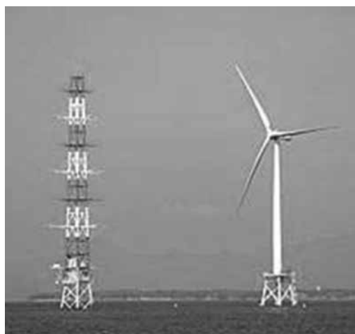
図表28 NEDOの着床式洋上風力発電実証事業 銚子沖の2.4MW、重力式基礎 北九州市響灘沖の2MW、ジャケット式基礎
