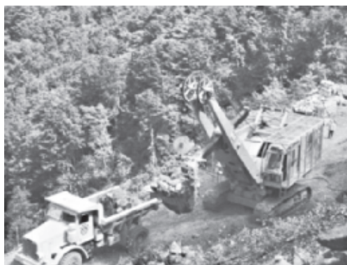
図表2 機械式電動ショベルU23(1962年)
