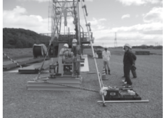
図表16 学校敷地内での掘削実習
