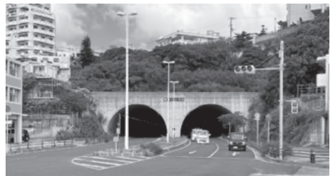
図表2 県道真地久茂地線 識名トンネル
