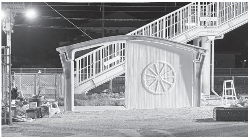
(注記) 鉄筋コンクリート造の10平方メートル弱の平屋建て駅舎。高さ約2.6 m、幅6.3 m、奥行2.1 m。壁面には、3Dプリンターの積層痕を生かしたデザインとして、有田市の名産「みかん」「たちお」をイメージした造形を実施。本稿末尾の供用前の完成写真も参照されたい。
