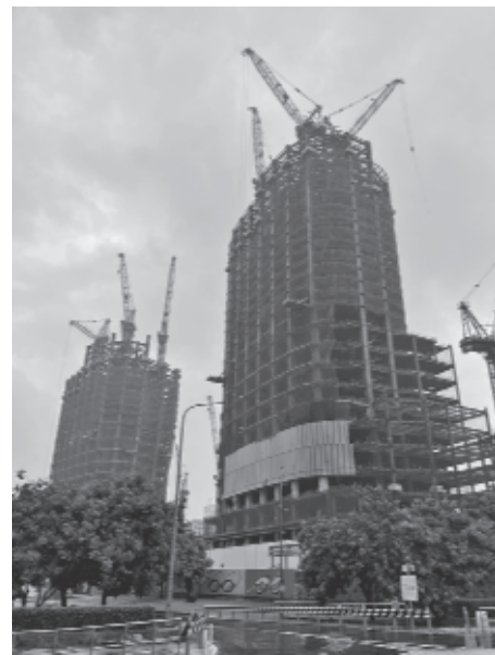
図表6 台北駅前で建設が進む高層オフィスビル
