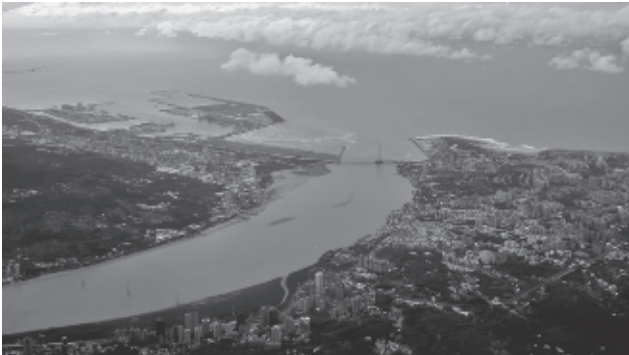
図表8 淡水河口における橋梁建設事業 (右が淡水地区、左が八里地区、左上が台北港)
