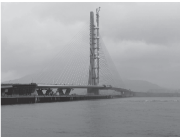
図表9 工事が進む淡江大橋建設事業
