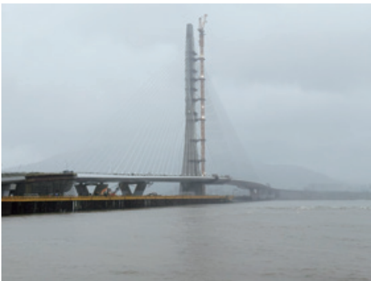
【図-9 工事が進む淡江大橋建設事業】
