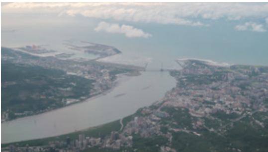
【図-8 淡水河口における橋梁建設事業 (右が淡水地区、左が八里地区、左上が台北港)】
