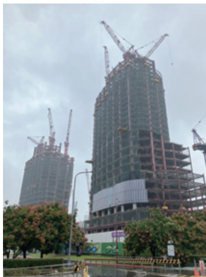
【図-6 台北駅前建設が進む高層オフィスビル】
